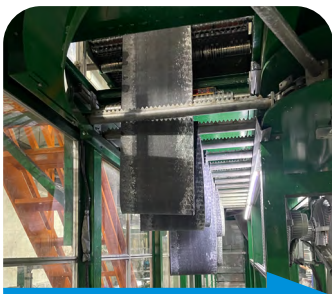
自動吊掛冷卻
